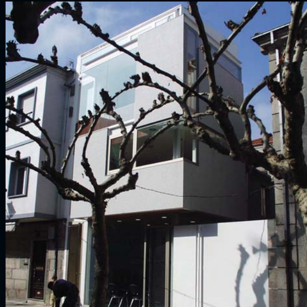
Santiago Barge Ferreiros / Belén Bouza Cora EDIFICIO DE OFICINAS Xinzo de Limia, 2004
